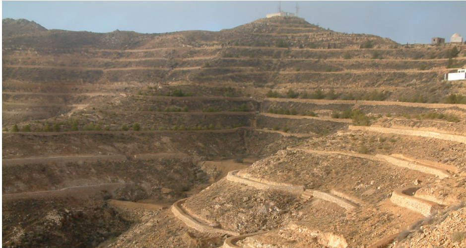
Photo 3 : Travaux de CES sur un parcours en pente
